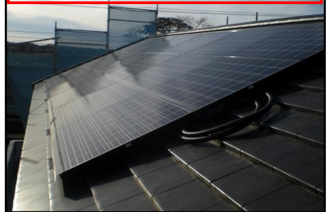
平成28年3月20日モジュール設置後
