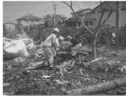
▲被災地でがれきの撤去を行う商工会青年部員
