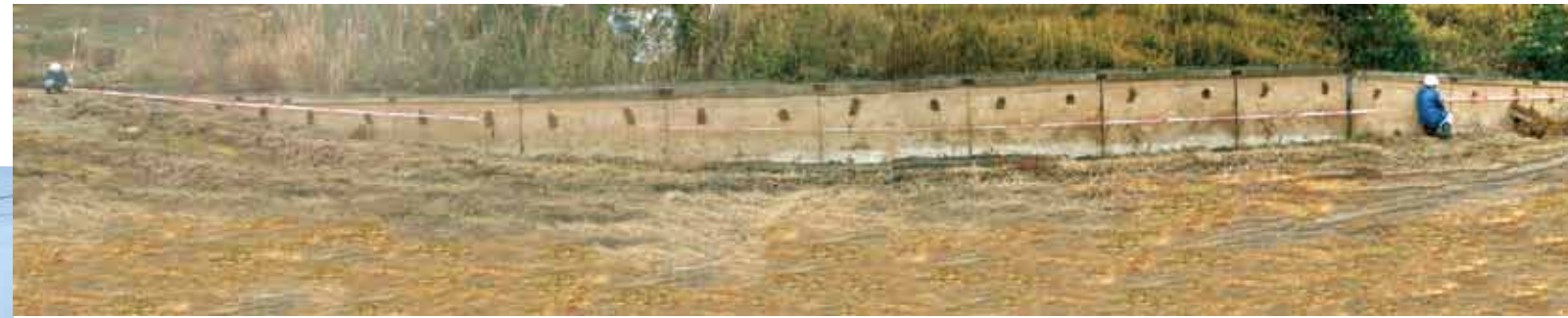
長門川5号雨水幹線の液状化現象。開水渠隆起によって排水機能が低下した
