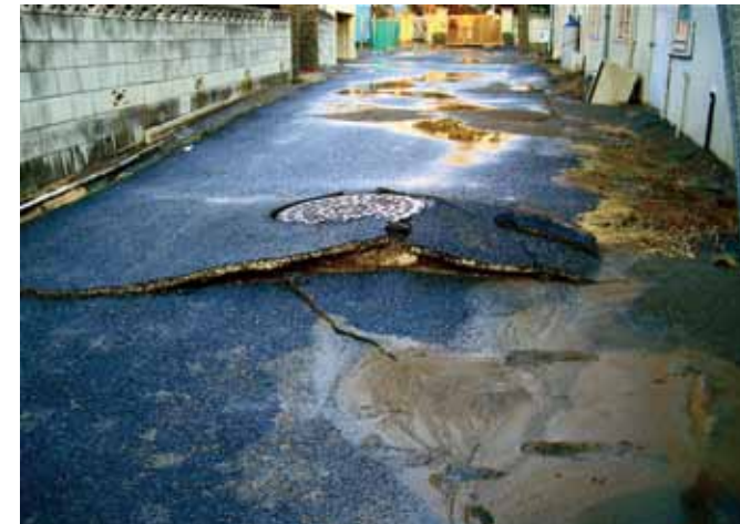
旧保健センター脇の液状化
