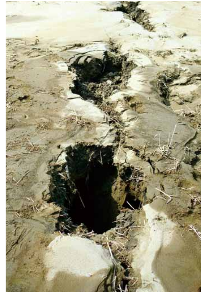
布鎌地区：液状化現象が発生した
