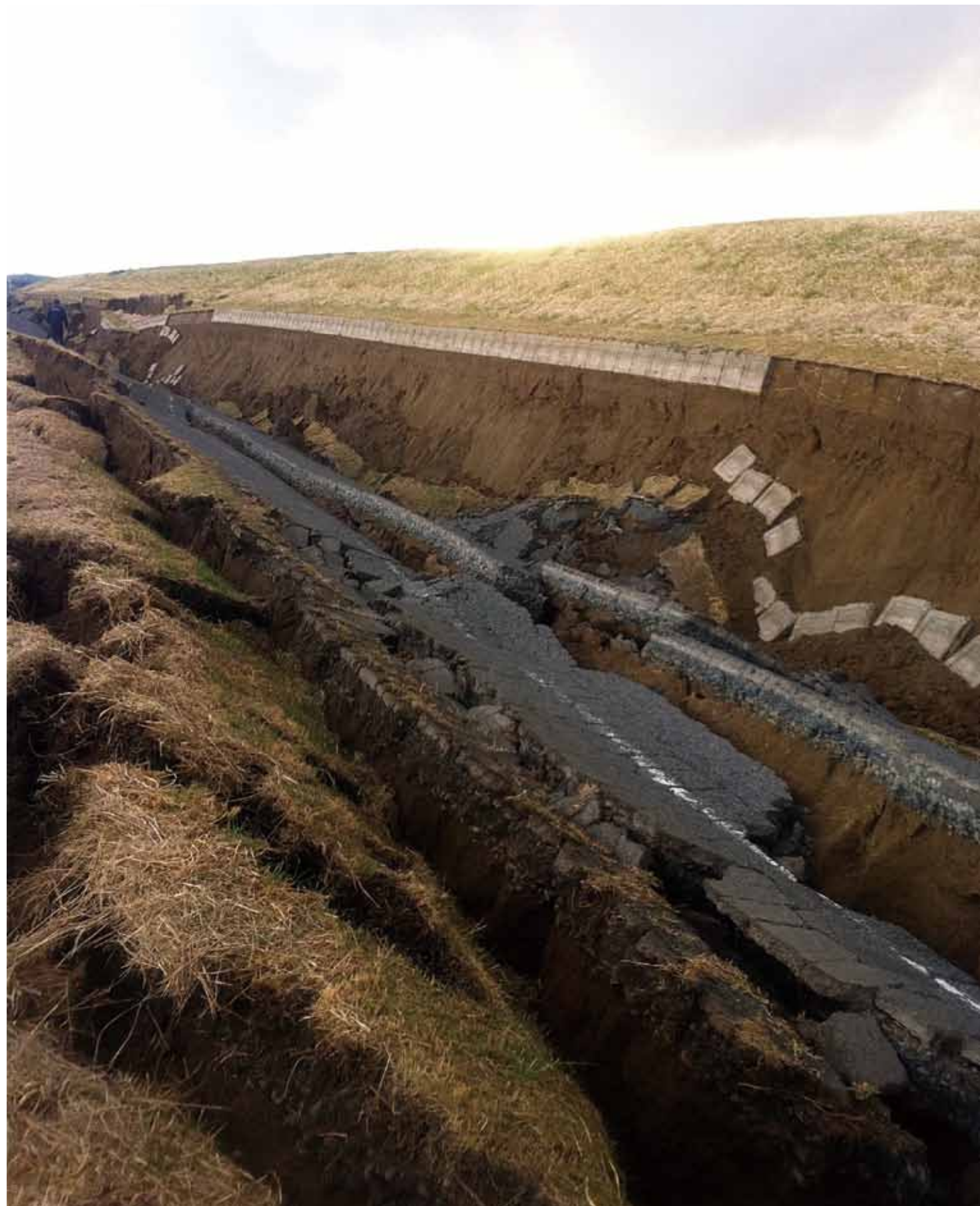
三和地区：利根川堤防沿いの道路が崩落
