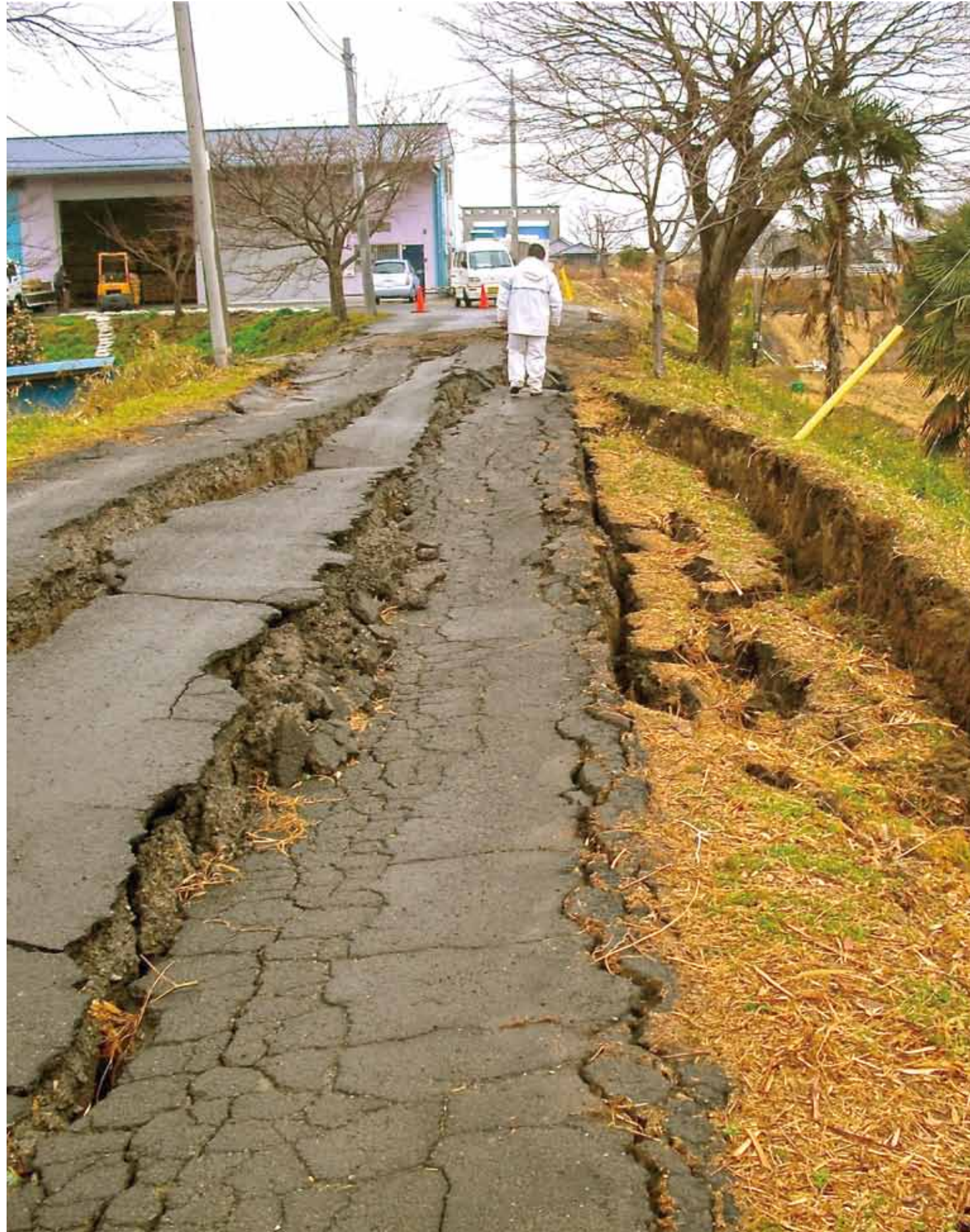
和田地区：旧利根川堤防緑耕舎付近の道路が断裂し、通行止めとなった
