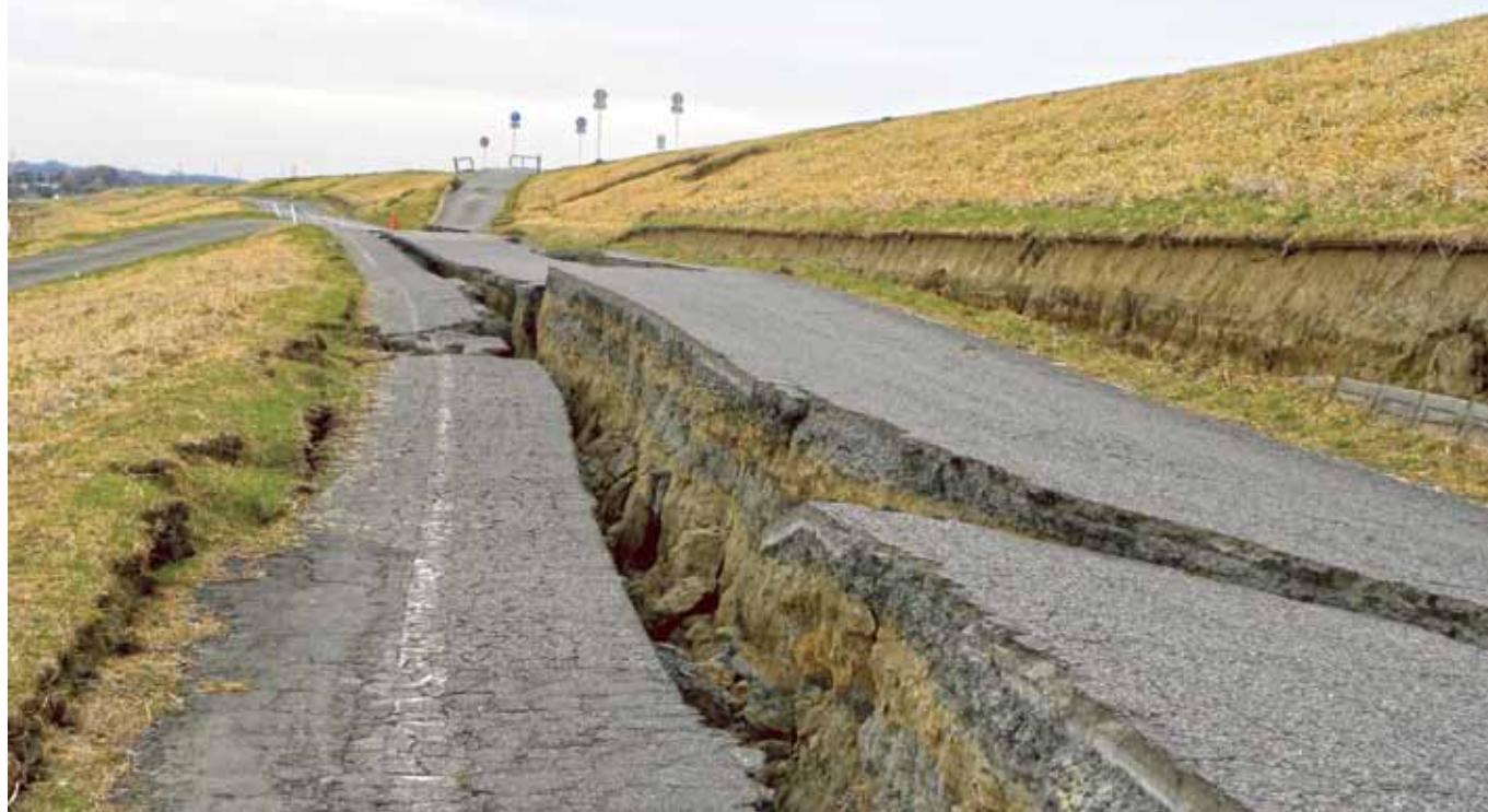
利根川堤防の被害は広範囲にわたった
