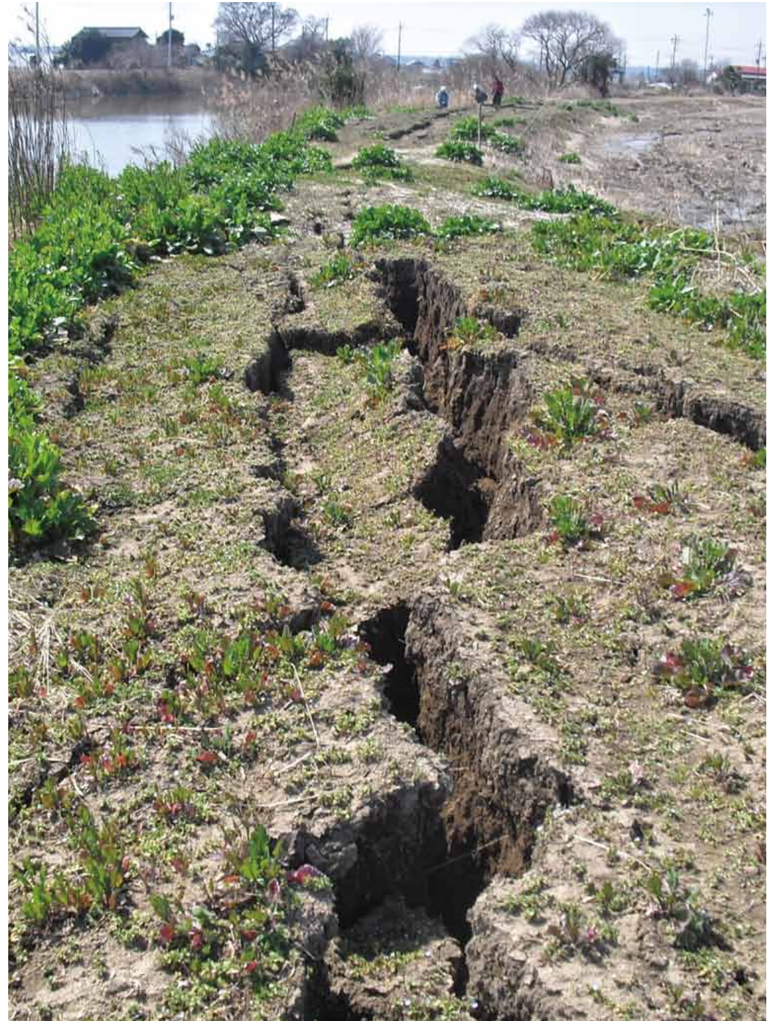
向洲地区：長門川堤防では地割れを起こした
