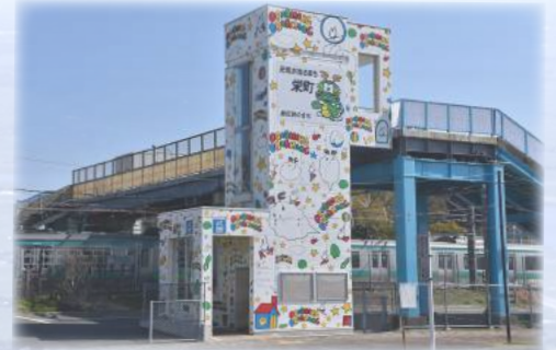
安食駅南北自由通路エレベーター
