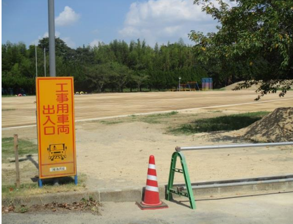
安食台小学校グラウンド改修工事
