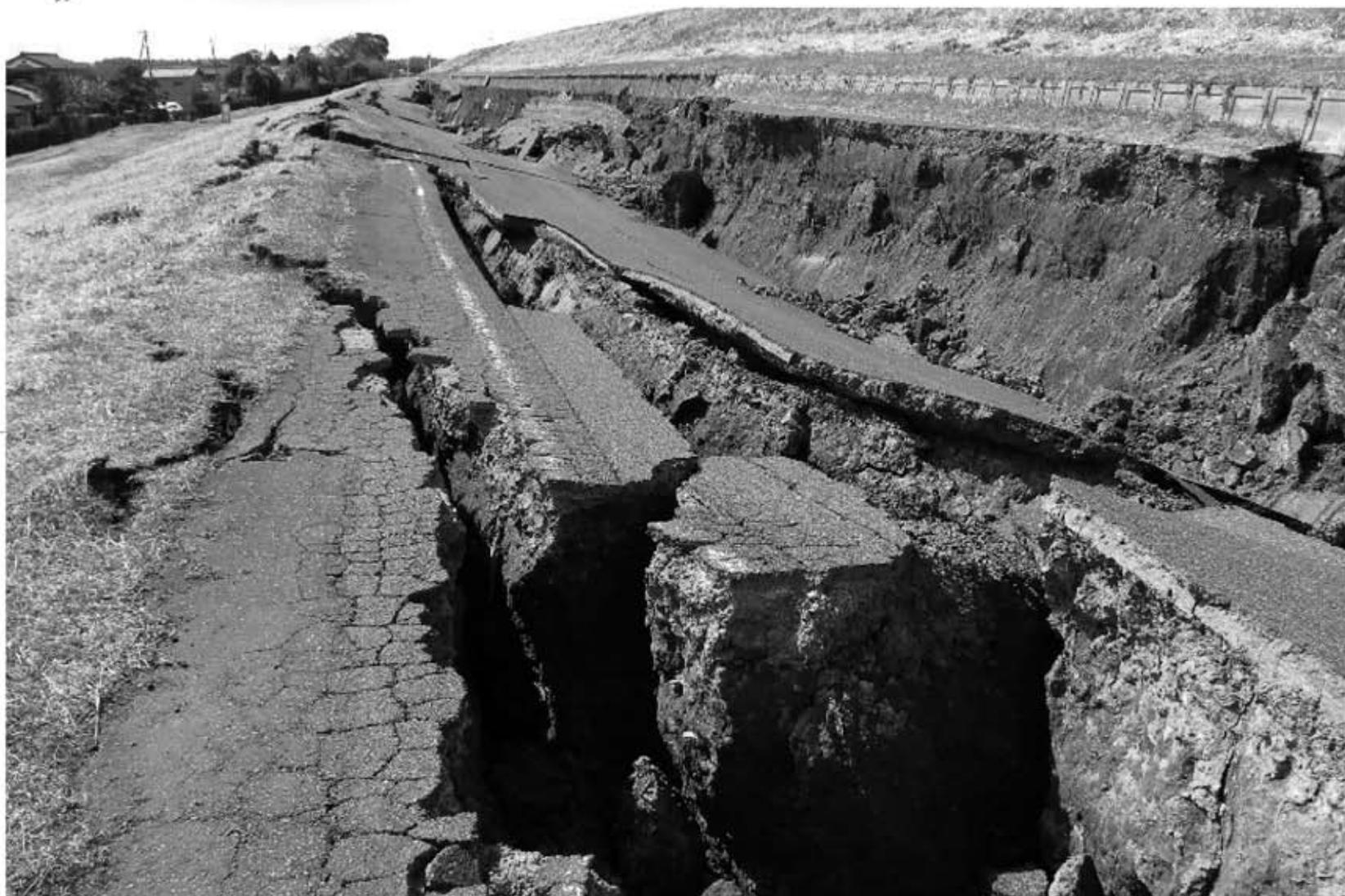
▲3月11日に発生した東北地方太平洋沖地震では、地震の大きさを物語っているように、利根川堤防沿いでは道路が東西方向に大きな亀裂が生じ、土砂が家屋に押し寄せるなど町も大きな被害を被りました。【関連記事2～3頁】
