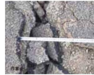
大芝土手前新田浄水場付近の道路亀裂と緊急対応状況
