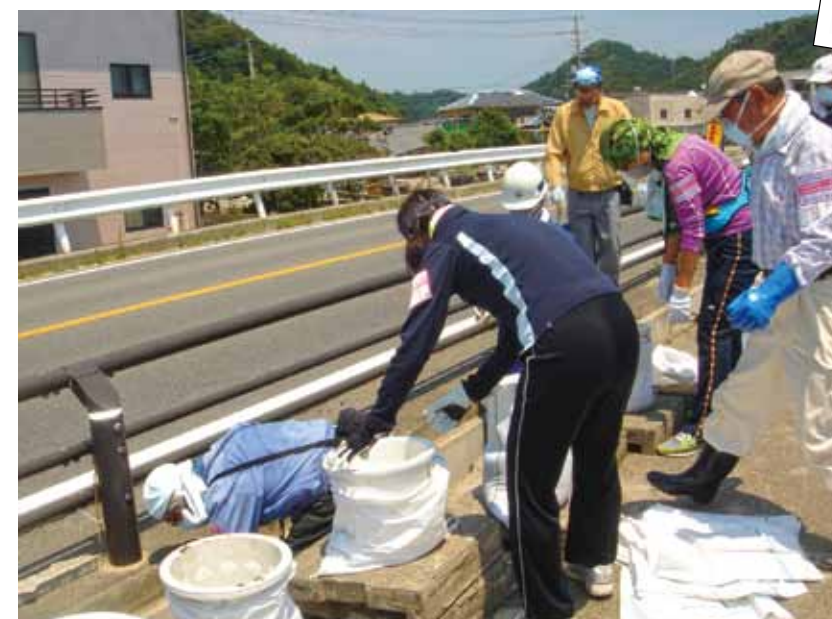
7月14日 いわき市永崎で側溝清掃をするボランティア
