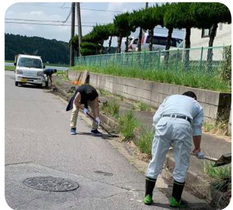
▲道路の土砂を取り除き、水たまりができないようにします
