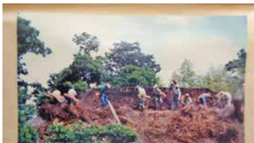
▲川崎家茅葺の古民家の解体の様子
