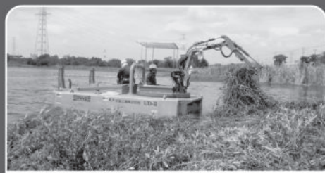
●水陸両用作業船：コンバー(写真) ●アオコ除去装置：アルデア
