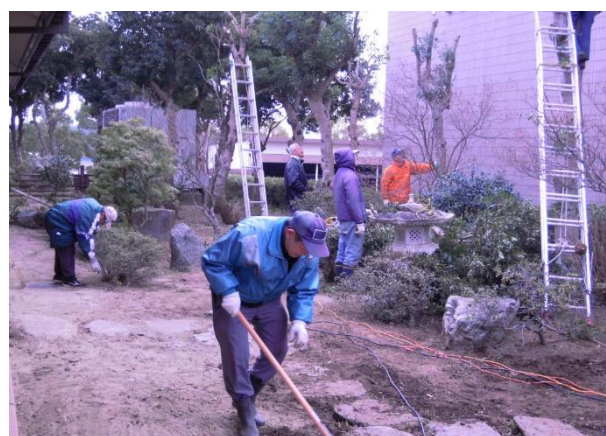
悠遊亭の庭園整備中
